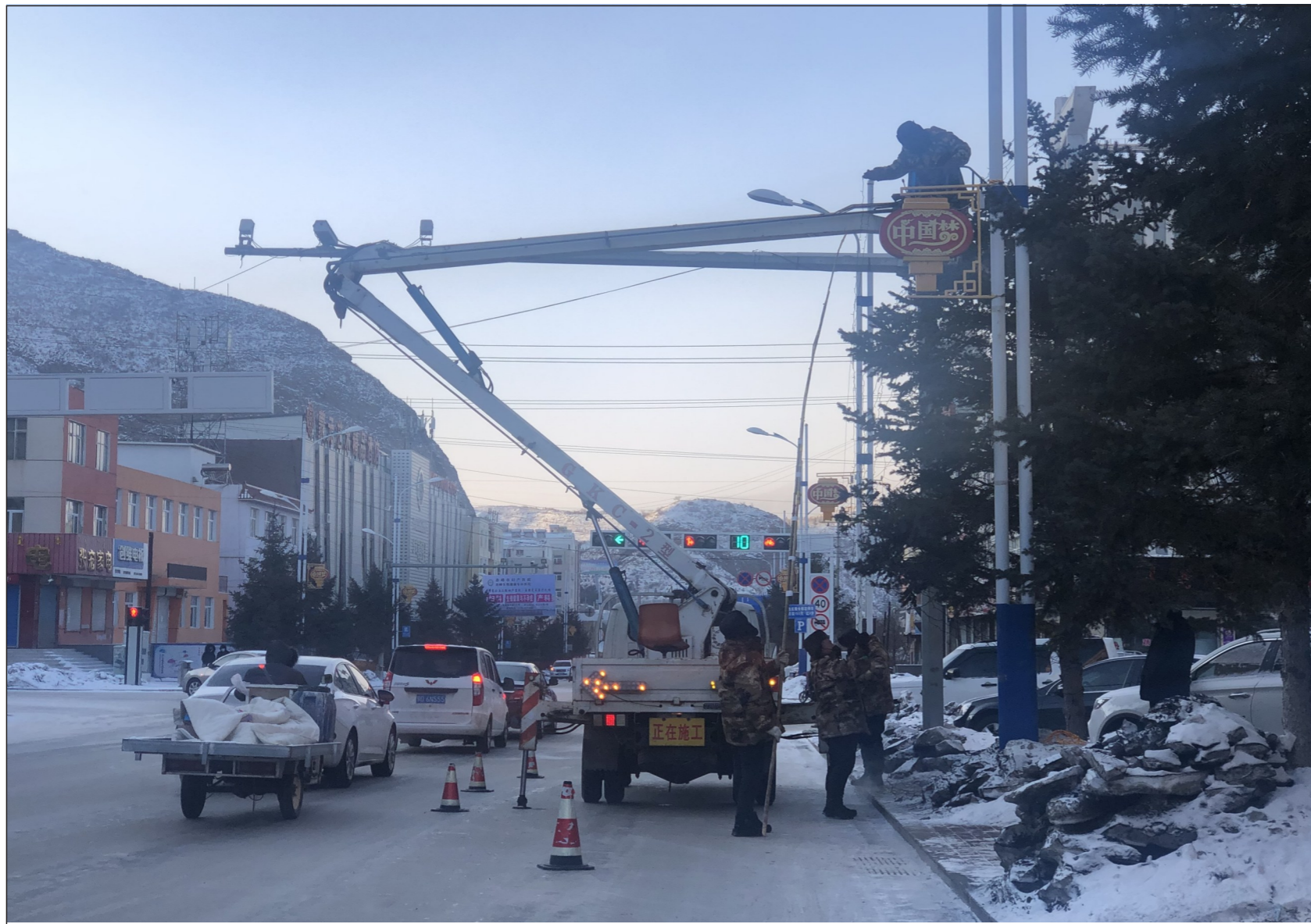
1月29日,经棚镇解放路南段工人正在安装节日彩灯,为喜迎新春做准备。 摄影于永波
