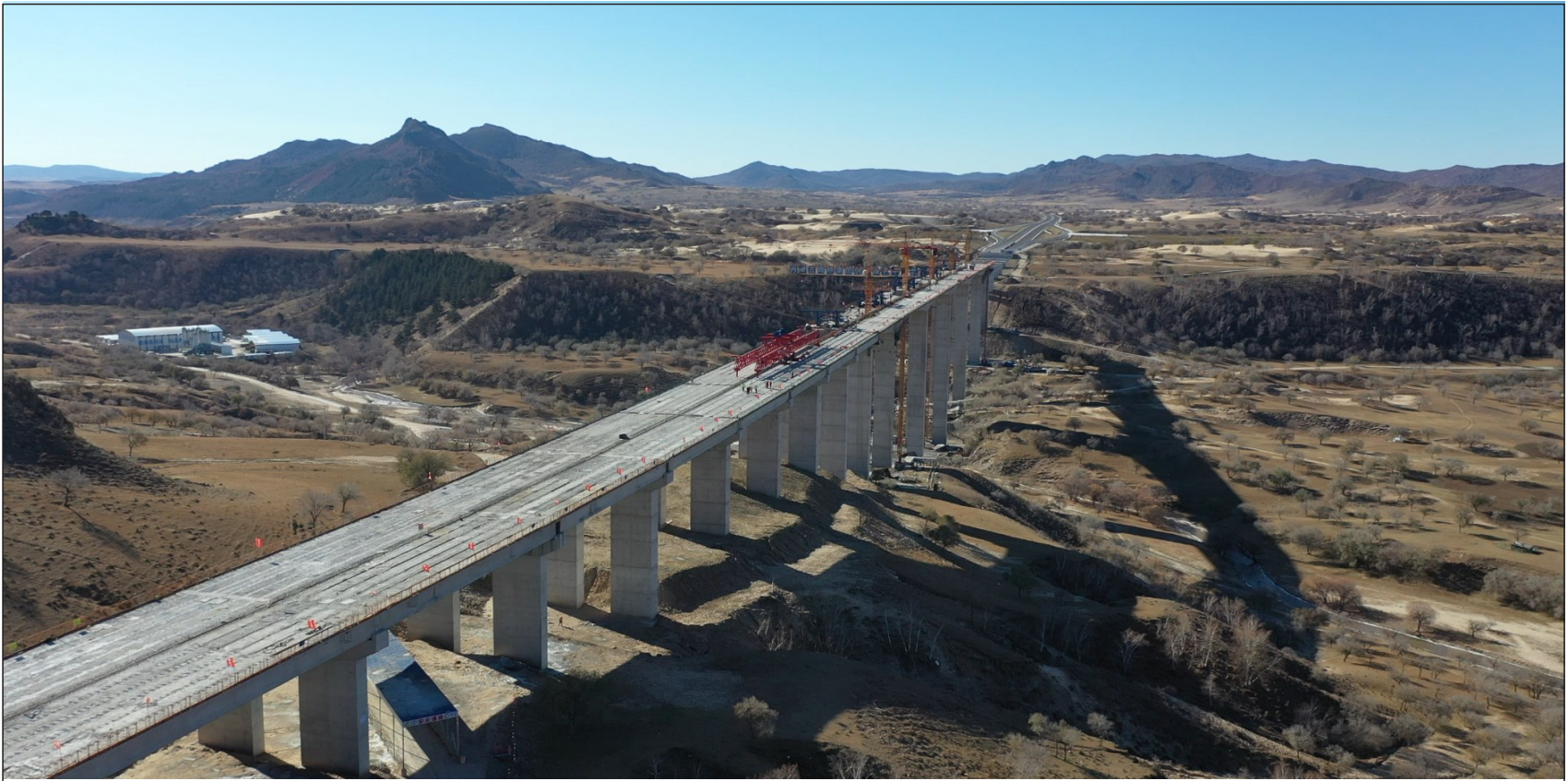
丹锡高速克什克腾至承德联络线经棚至乌兰布统段高速公路项目萨岭河大桥主桥于10月17日上午实现全幅合龙。桥梁全长988米，共建墩台二十个，最大墩高达80.5m，相当于27层楼高，主桥采用挂篮施工工艺，总投资约2.2亿元。摄影 杜海龙
