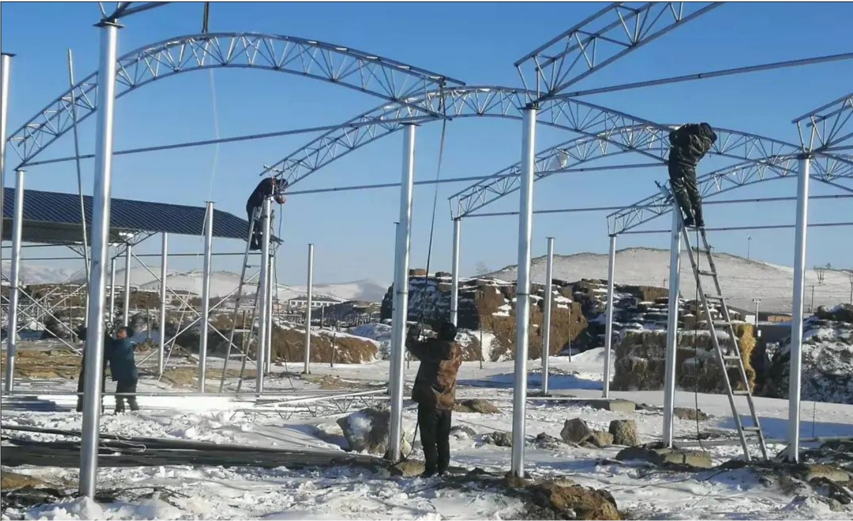
今年,乌兰布统苏木为常住养殖户争取储草棚项目446处,每处200平方米,可储干草20万斤。截至目前,已有251处储草棚投入使用,其余195处正抢抓工期,预计2022年2月前全部建成投入使用。图为储草棚施工现场。
