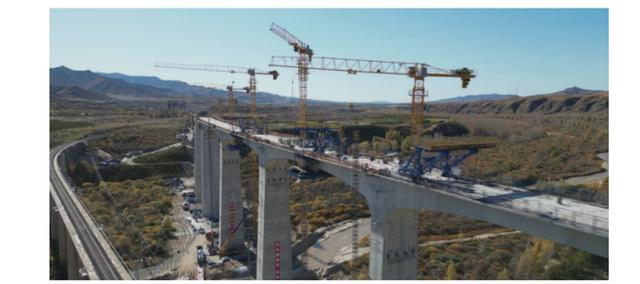
本报讯（记者 王莹莹）近日，集通铁路电气化改造工程全线最大跨度的多伦河特大桥连续梁顺利合龙，为全线架梁通道畅通奠定坚实基础。
